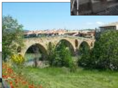
Le pont sur l'Arca de Puente la Reina.
