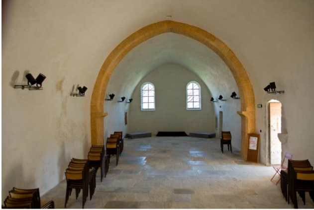
Après restauration, Intérieur de la Chapelle St Jacques...
